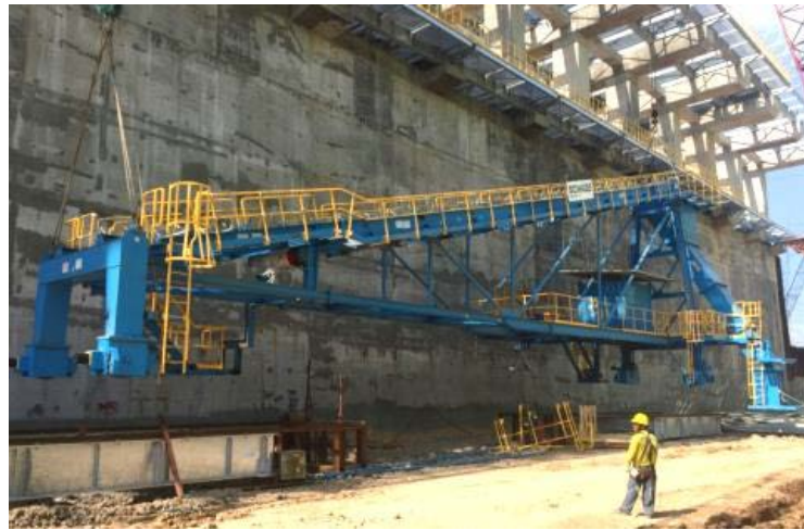
Foto 2: Der Abwurfwagen wurde komplett vormontiert und mit Hilfe von Kranen auf die Schienen gehoben. (Foto SCHADE)
