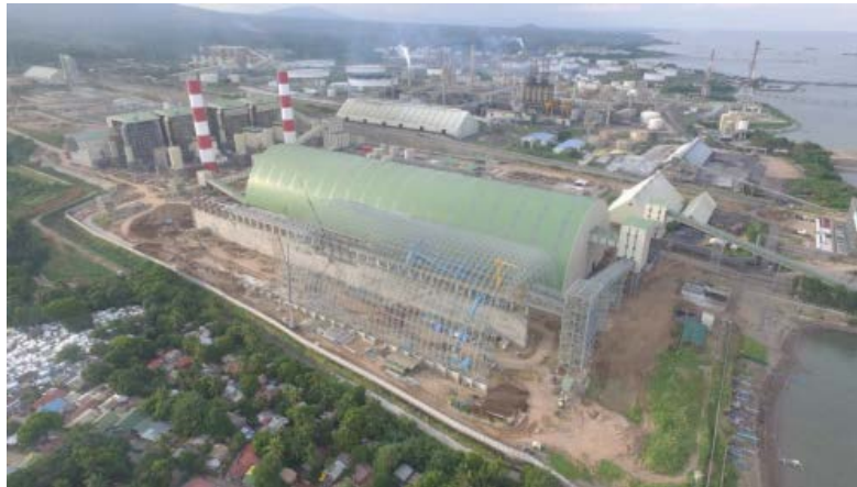
Foto 1: Derzeit läuft die Montage im Projekt Limay II (Foto SCHADE).
