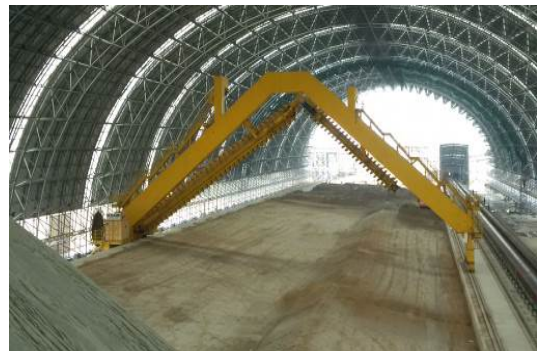
SCHADE-Portalkrater und SCHADE Kreislager (Fotos SCHADE)
