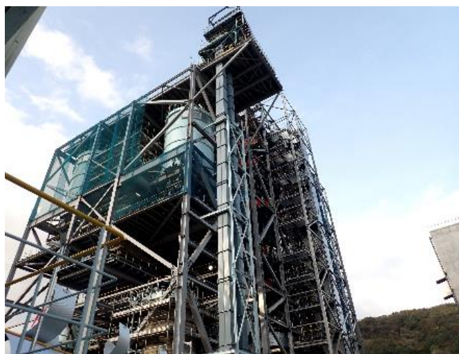
Das AUMUND-Becherwerk mit Schwerkraftentleerung Typ BWZ-S ist seit Herbst 2019 im Kraftwerk Ofunato im Einsatz (© AUMUND).
