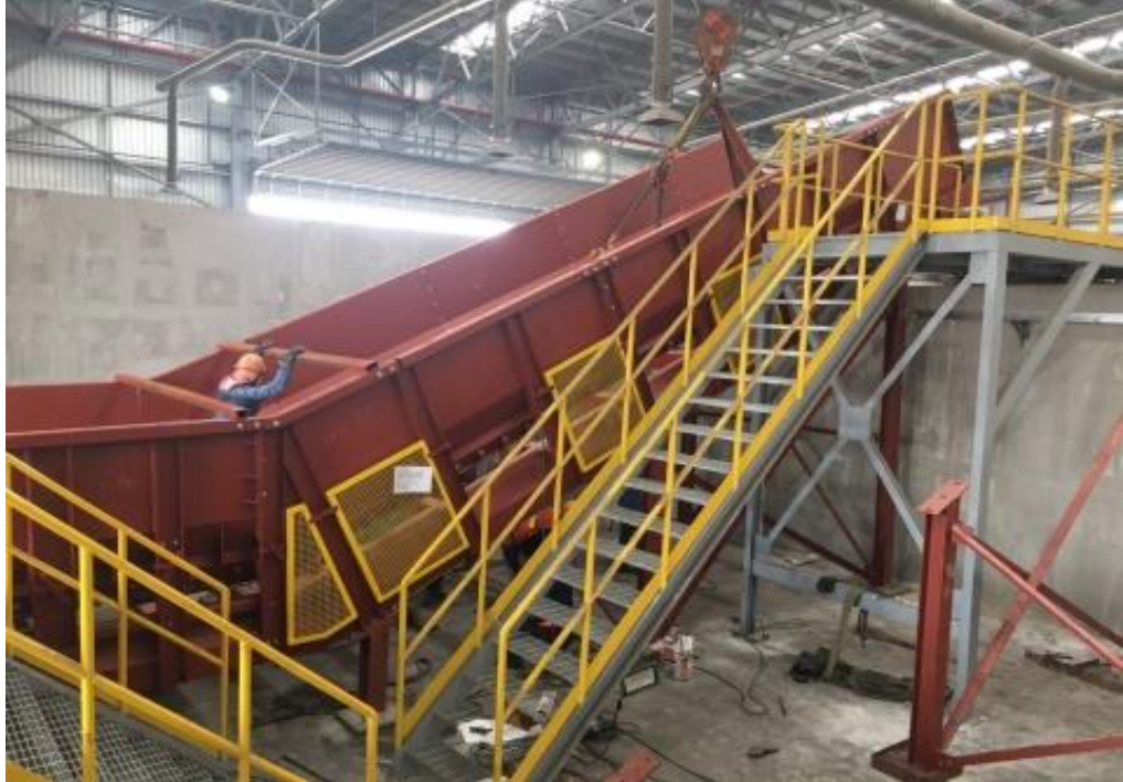
Vor-Ort-Installation des Samson® Materialförderers (alle Fotos AUMUND)
